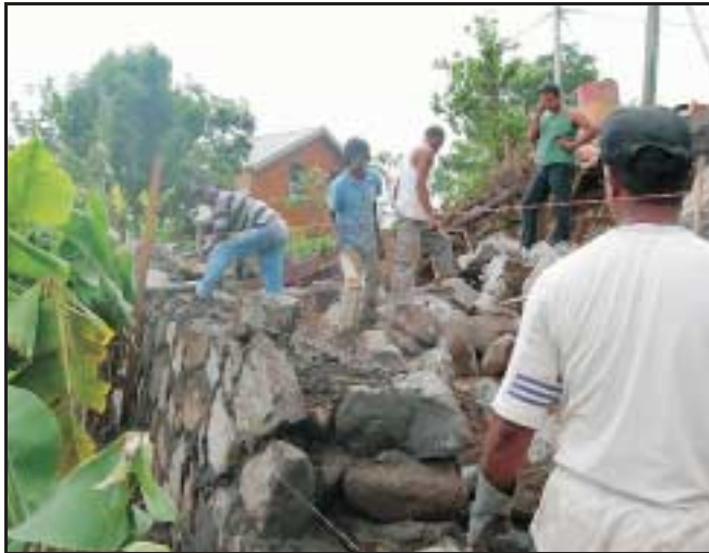
Semelle bien dimensionnée, largeur de la base adaptée à la hauteur du mur, croisement spécifique des pierres, barbacanes pour l'évacuation des eaux... La construction d'un mur de soutènement obéit à des règles strictes.
