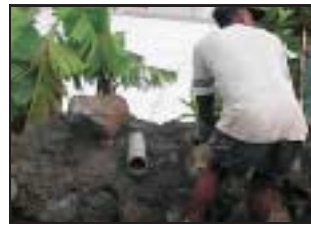
Semelle bien dimensionnée, largeur de la base adaptée à la hauteur du mur, croisement spécifique des pierres, barbacanes pour l'évacuation des eaux... La construction d'un mur de soutènement obéit à des règles strictes.
